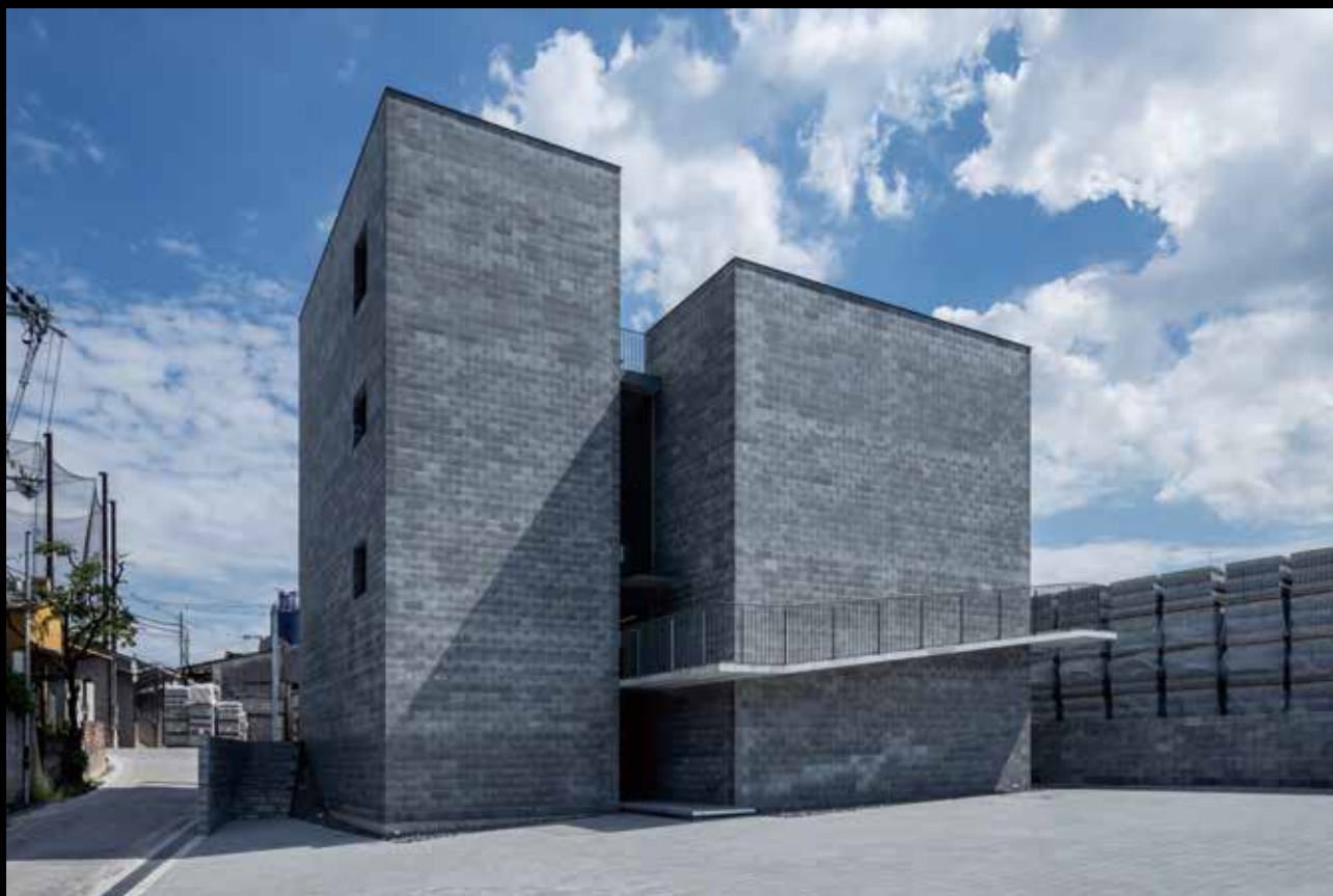
北側外観：敷地入口の正面にあたる。開口を廃してブロックの量感・質感を最大化した。
