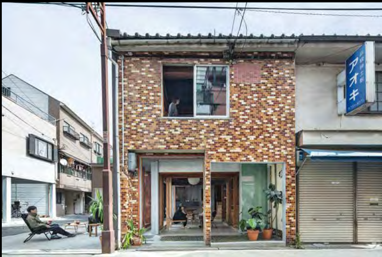
西側外観：玄関扉を外し、外壁の一部を解体し、内側に新たに壁と建具を設けて、1階平面の外周部を半屋外空間とした。
