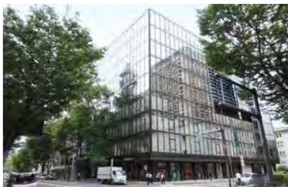
東側からの外観全景
