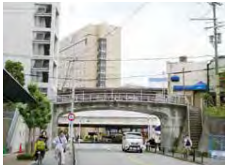
橋が架かっている高い部分が文禄堤
